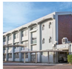
7 特別教室棟西館
