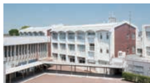
3 特別教室棟西館
