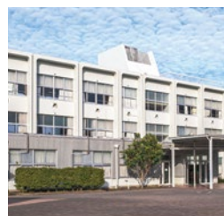
8 特別教室棟東館
